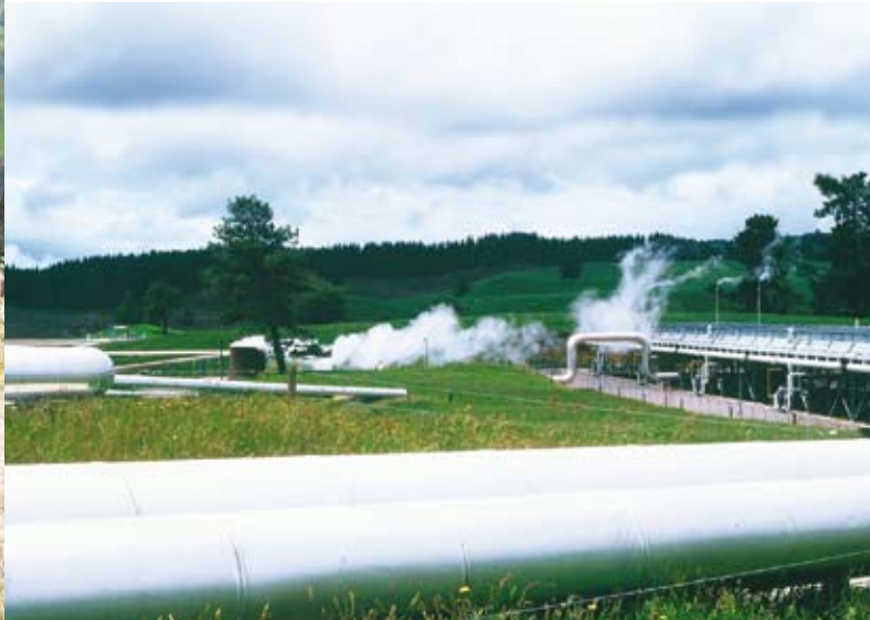
الأنابيب الناقلة لبخار الطاقة الحرارية الأرضية في الفلبين
